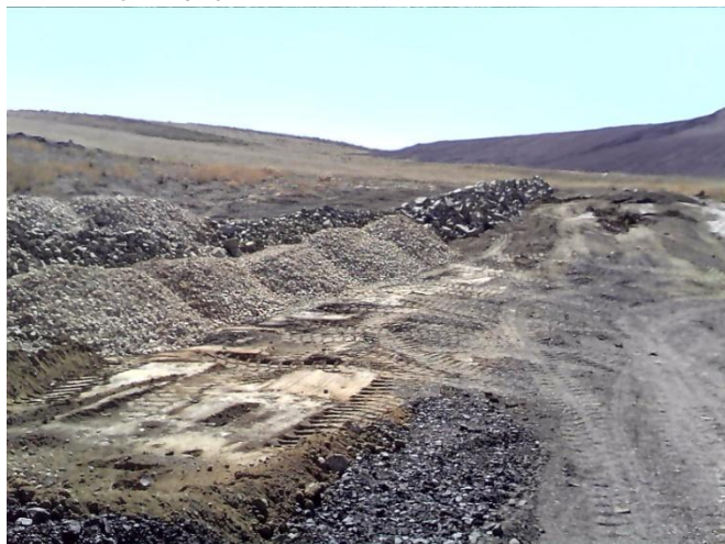
RDA Underdrain Construction
