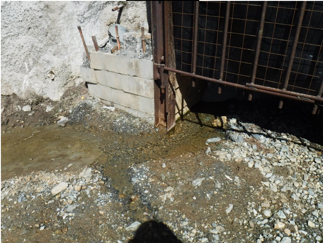
Photo 1: Idaho Tunnel effluent discharge
