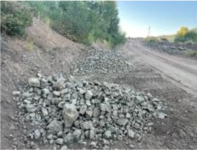
Rock Dam 2.jpg 33K
