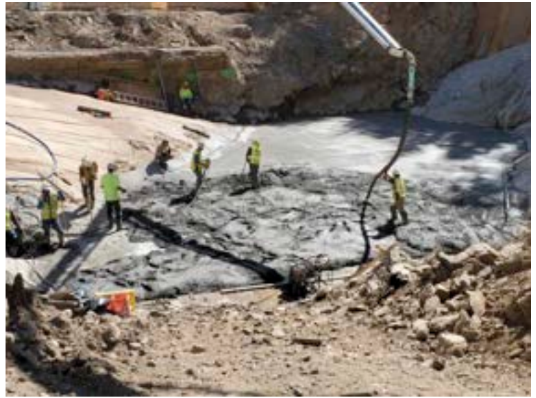
Another pour of leveling concrete
