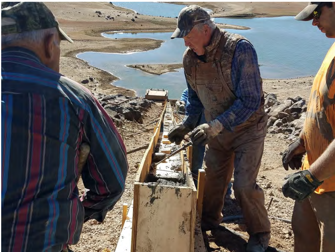
Photo 7 Pour complete at 2:21 pm
