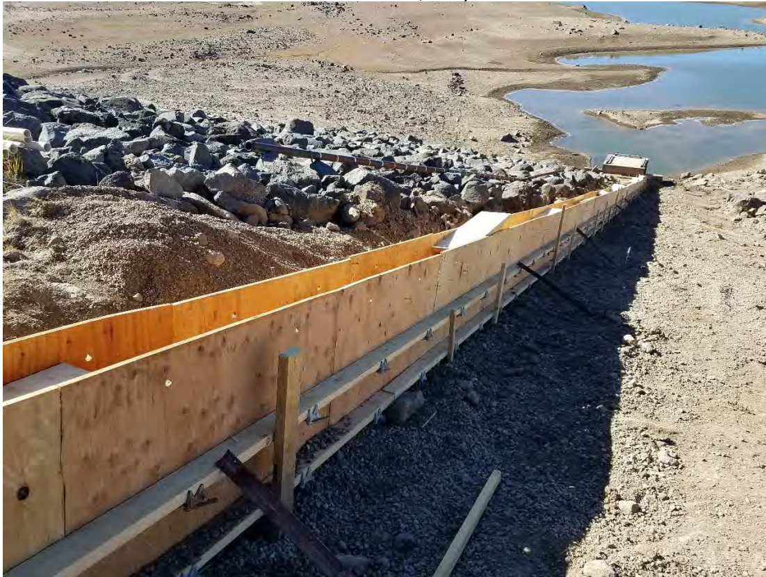
Photo 1 Forms ready for pour
