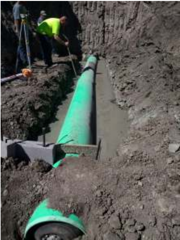
Fig 3: Crews adjust pipe after 1 st pour
