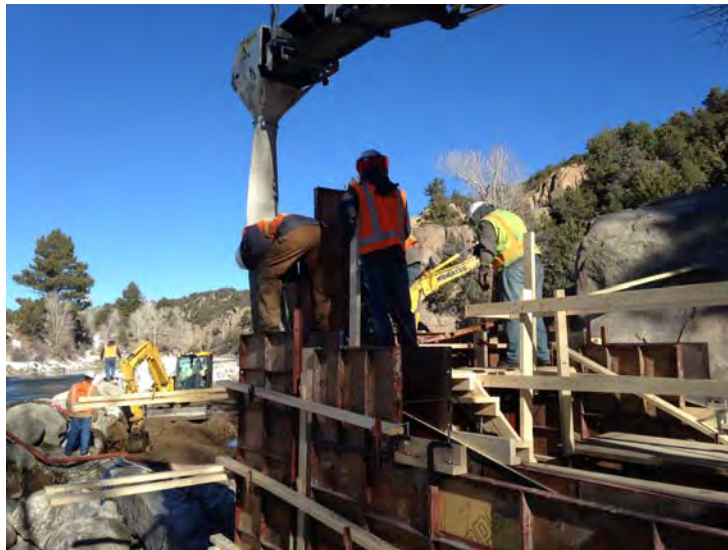
Concrete pour headwall & walls Phase 1
