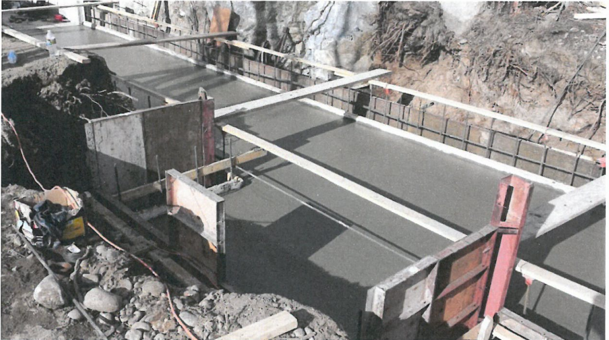
Concrete pour of floor
