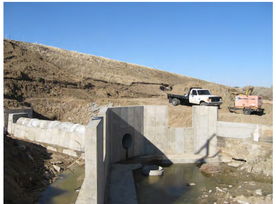
PHOTOGRAPH 6 — OUTLET CONDUIT EXTENSION
